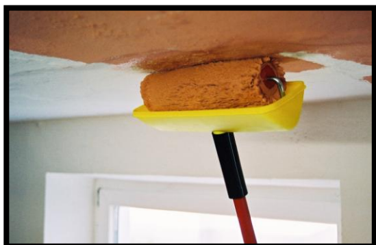
Drypfri maling af loft, vægge og gulve - takket være dryp-bakken
